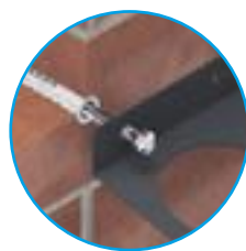
Fissaggio su muro
